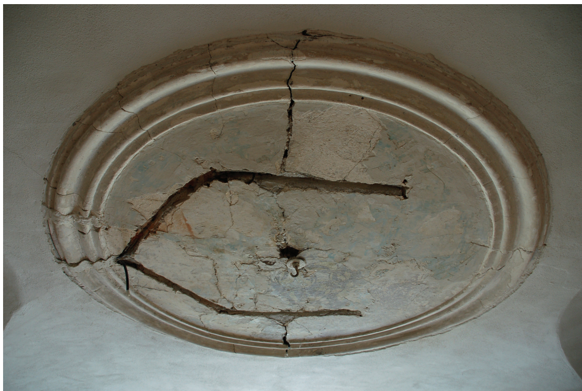
Stav po odkryvu, průběh odstraňování nevhodných vysrávek.
