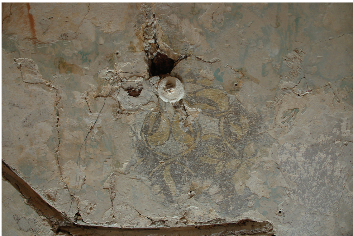
Stav v průběhu hloubkové injektáže. Detail nálezu fragmentu rozety na jedné z nejmladších vrstev. Viditelné množství prasklin a defektů.
