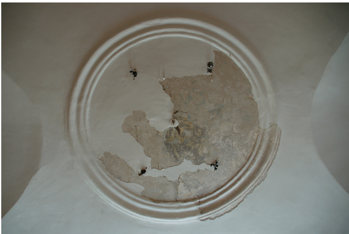
Stav v průběhu odkryvu.
