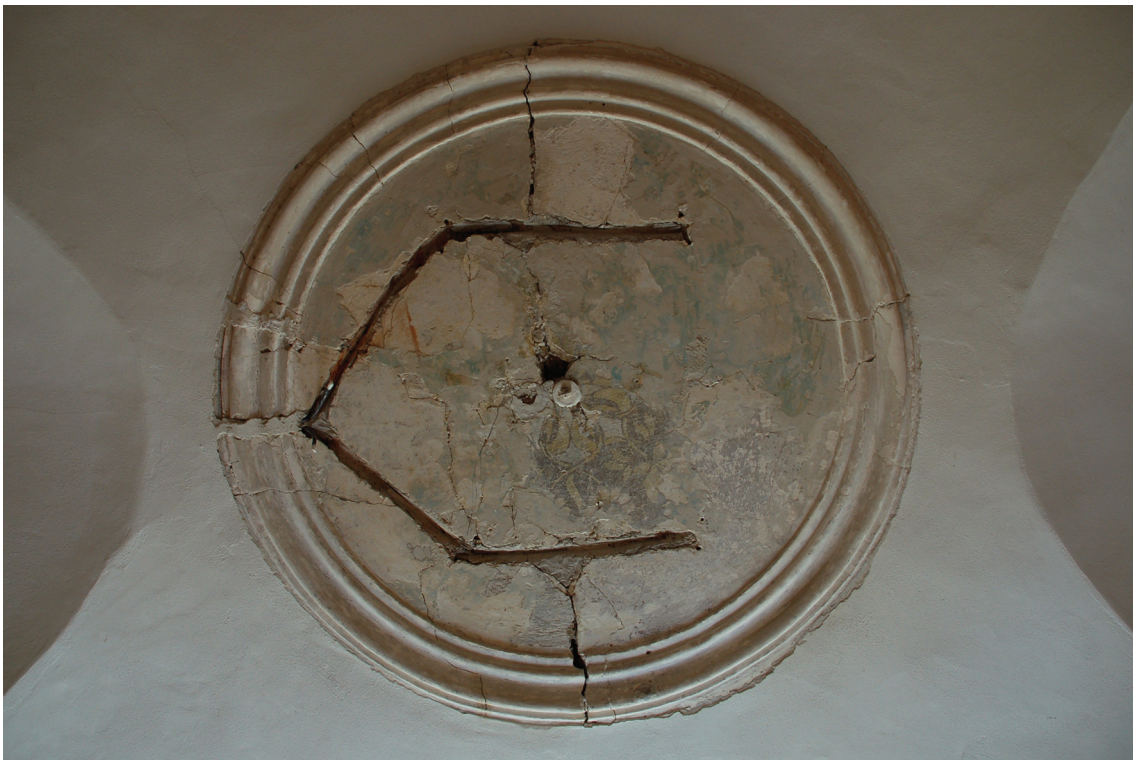
Stav v průběhu odstraňování nevhodných vysprávek.
