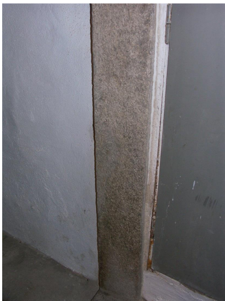
části portálu v průběhu oprav
