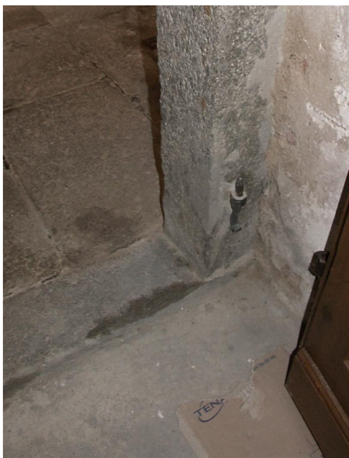
části portálu v průběhu oprav
