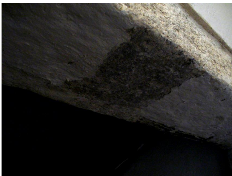
postup snímání omítek z povrchu kamene
