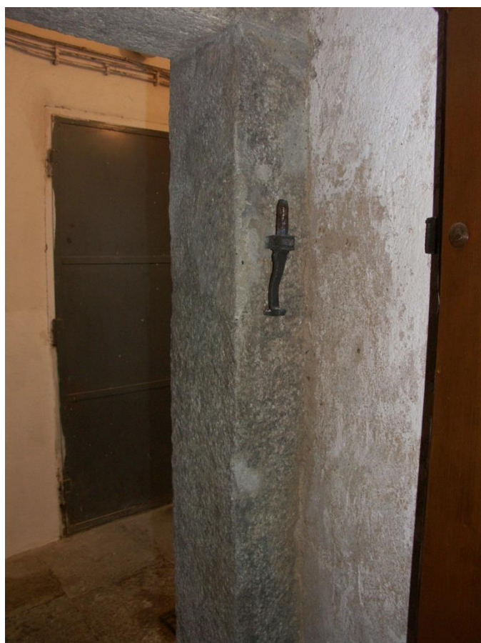
části portálu v průběhu oprav
