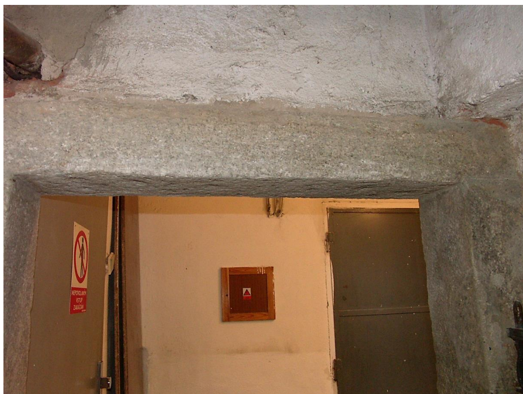
části portálu v průběhu oprav
