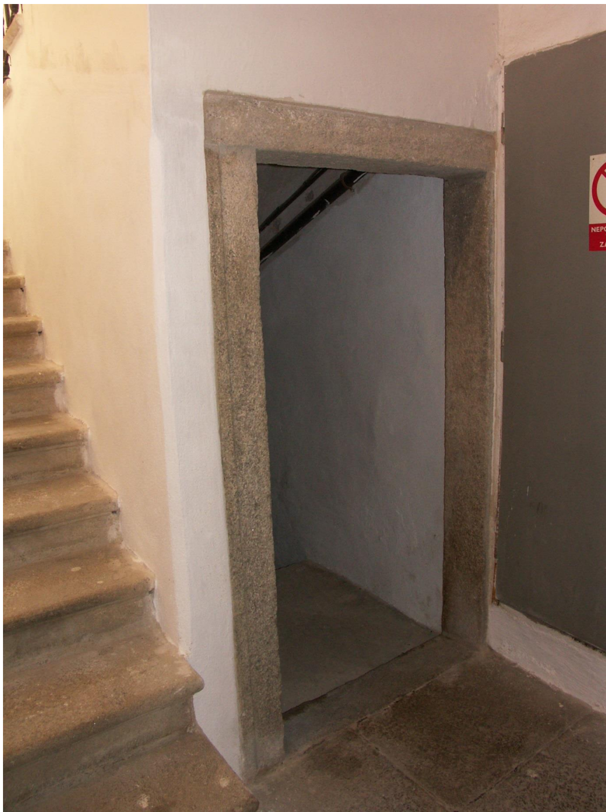
ostění vstupu – konečný stav po restaurování
